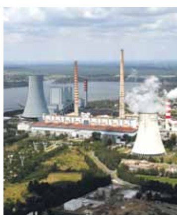
ELEKTROWNIA W RYBNIKU (fot. Michał Major)
